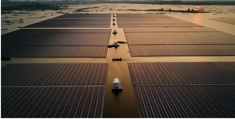
40 MW Huainan - China
